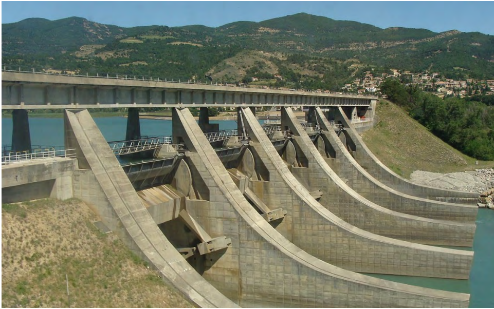
Barrage de l'Escale sur la Durance (Alpes de Haute Provence)
